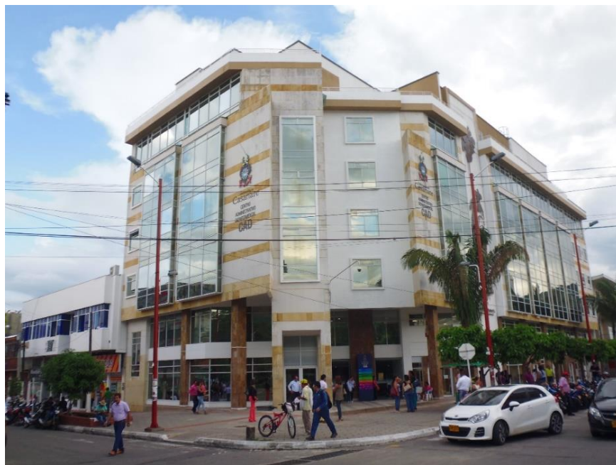
Ilustración 1. Centro Administrativo de la Gobernación
