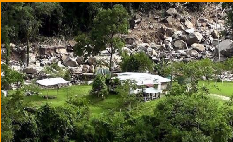
Foto No.09 – Vivienda en riesgo por deslizamiento, ubicada en la Vereda el Vegon del municipio de Recetor.
