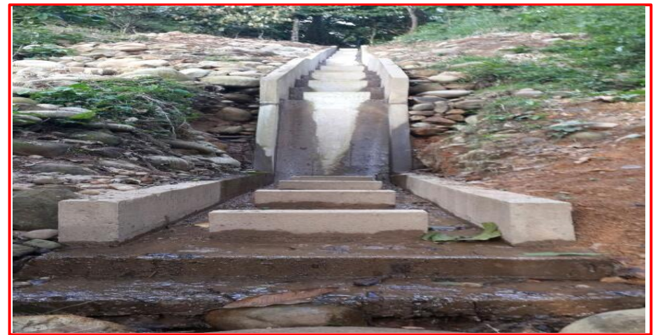
Foto 4. Vista general del estado final torrentera zona deslizamiento 2.
