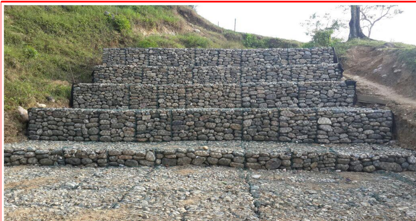
Foto 1. Vista frontal del estado final muro escalonado zona deslizamiento 1.
