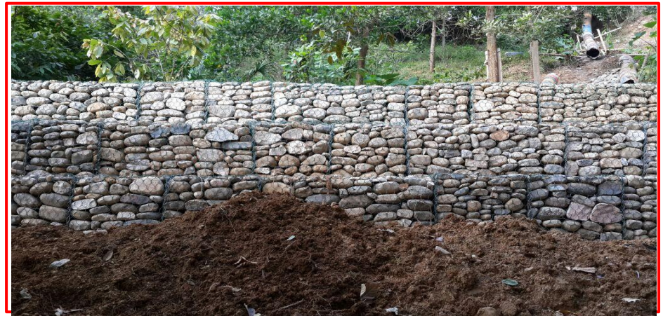
Foto 2. Vista posterior del estado final muro escalonado zona deslizamiento 1.
