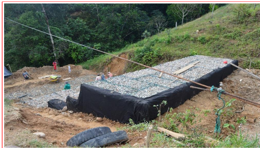
Foto 3. Vista general del estado final muro escalonado zona deslizamiento 2.
