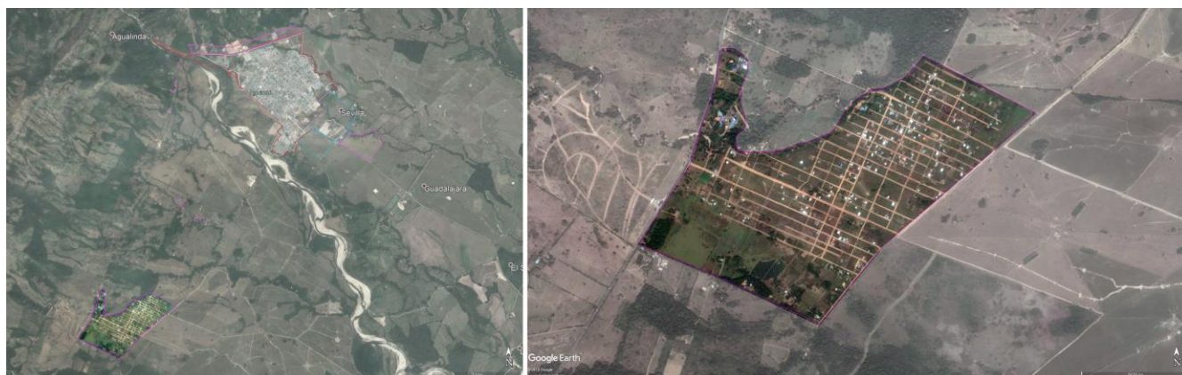
Ilustración 79. Asentamiento informal en Aguazul Fuente: Elaboración propia con base a Google earth
