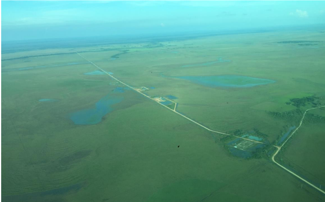
Ilustración 6. Infraestructura petrolera residual Fuente: Fotografía propia
